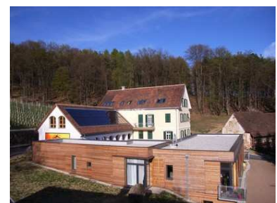
Abb.5: Gebäude-Ensemble des Wein- und Wohnresorts Feistritzer (im Vordergrund Neubau mit 7 Wohnungen)
