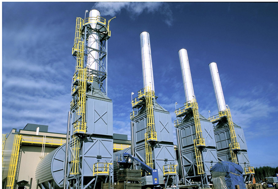
Abbildung 31: SAGD-Dampfgeneratoren
