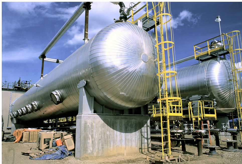
Abbildung 33: Separatoren
